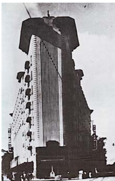
Figura 16 Edificio Edificio Ermita-Hipódromo, Av. Tacubaya, Ciudad de México. Arq. Juan Segura, 1929-1935. Perspectiva desde el cruce de Revolución y Jalisco. Testimonios vivos, 20 Arquitectos. SEP-INBA, México, 1981
