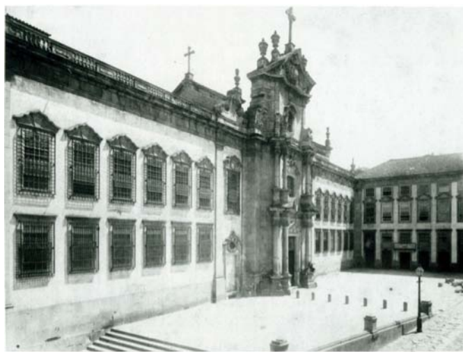
Figura 1 - “Emílio Biel fotografou largamente o Convento de Ave-Maria na fase final da sua existência (1886-87). Aqui podemos ver a fachada sul, virada à Rua do loureiro. Em primeiro plano estão as janelas do coro alto, depois o coro baixo, a entrada da igreja e, ao fundo, fechando o terreiro de entrada do edifício da sacristia (mais tarde utilizado como escola).” (in “Porto Desaparecido”, p. 72)
